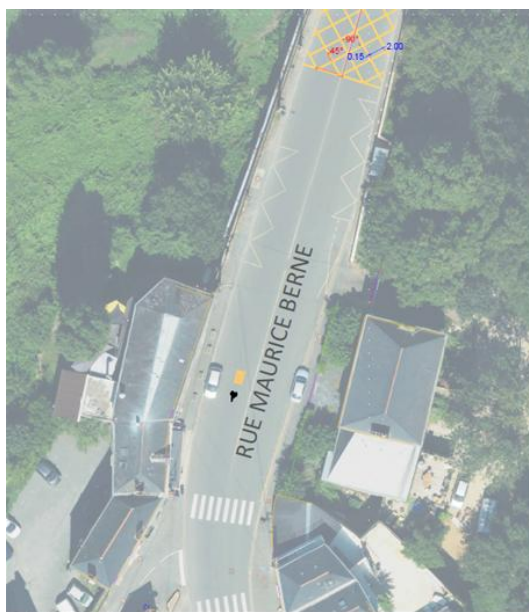
Ech: 1/250ème Rue Maurice BERNE _ Murs- Erigné (à proximité du Tabac)
