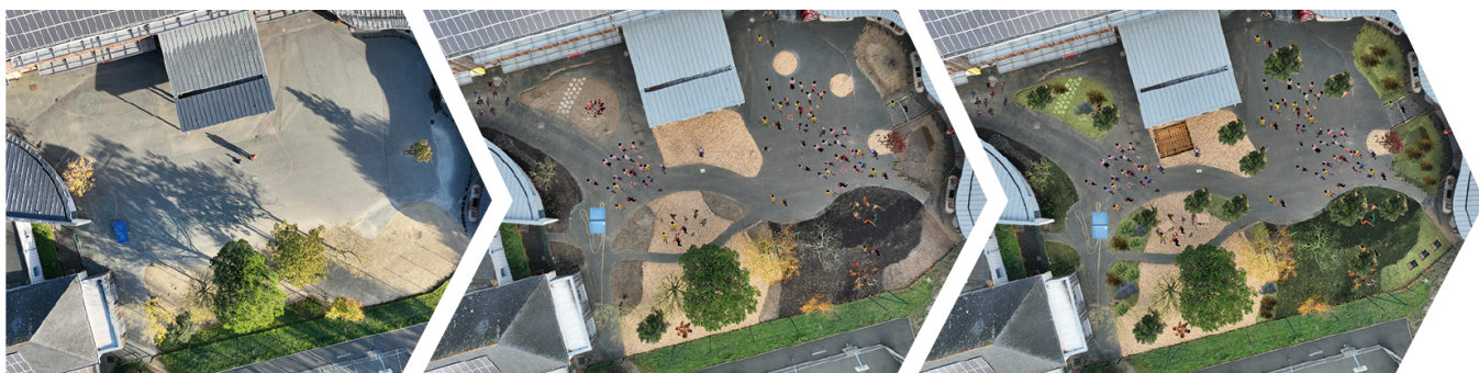
oct. 2025 - Avant travaux
