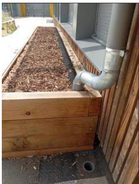
Jardinière réalisée par les services techniques, reliée aux gouttières et permettant à l'eau de pluie d'arroser les plantations qui seront installées aux vacances scolaires d'octobre 2026
